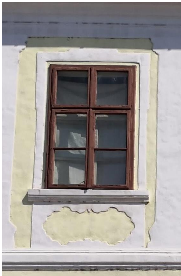
114. Ferestre cu tâmplărie dublă de lemn cu geam simplu, originale la interior cu vopsele pe bază de ulei albe, iar la exterior tâmplărie montată în 1962 și vopsită maro
