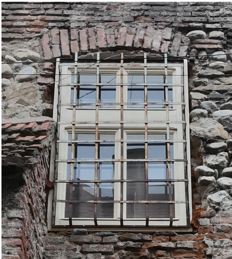
116. Fereastră montată în 1962 cu tâmplărie dublă de lemn cu geam simplu, vopsite parțial alb și grilaj metalic realizat din platbandă metalică sudată pe ramă metalică din platbandă fixat pe toc cu șuruburi și cu arc de descărcare din cărămidă aparentă
