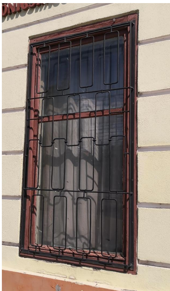
99. Ferestre montate în 1962 cu tâmplărie dublă de lemn cu geam simplu, vopsite maro la exterior, alb la interior și grilaj metalic realizat din bare rotunde cu ramă metalică din platbandă fixat pe toc cu șuruburi
