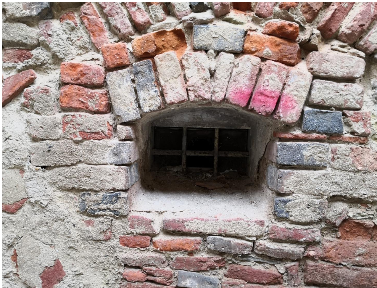
94. Goluri de ferestre la demisol cu grilă originală din fier forjat și ambrazură tencuită
