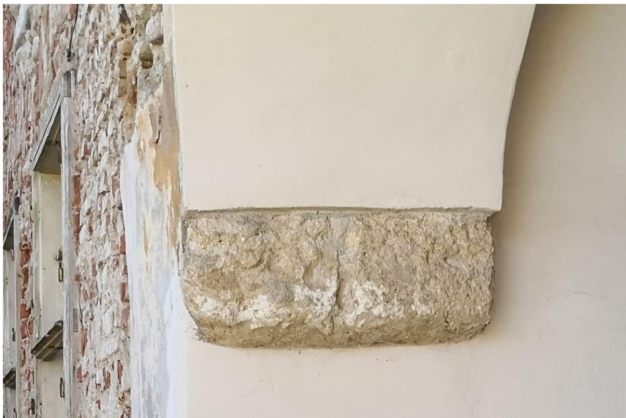
95. Consolă de piatră pentru descărcarea bolților semicilindrice cu penetrații, în P1
