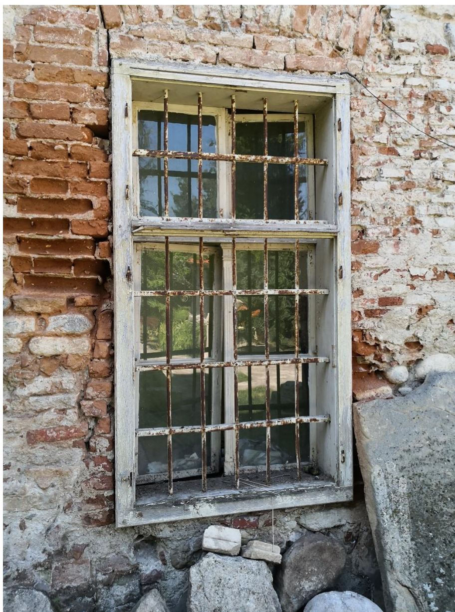
97. Fereastră cu tâmplărie dublă de lemn cu geam simplu, fără cercevele la exterior, cu grilaj original din fier forjat montat la mijloc și cu arc de descărcare din cărămidă aparentă
