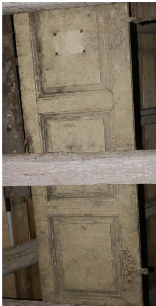
133. Canate de uși din pod cu feronerie baroce refolosite
