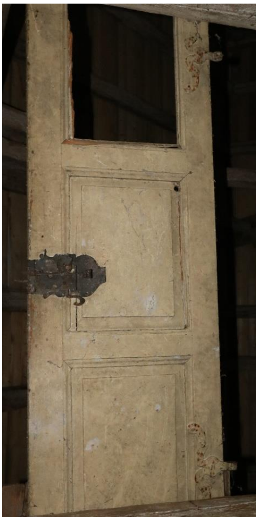
133. Canate de uși din pod cu feronerie baroce refolosite
