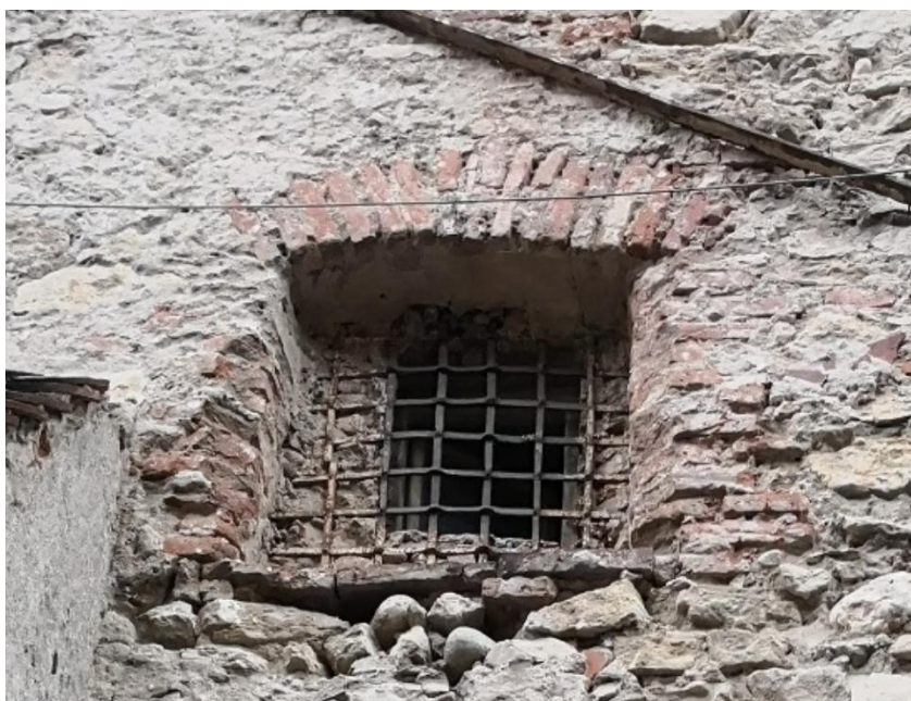
117. Gol de fereastră parțial zidit, fără tencuială, cu fereastră din lemn vopsită pe bază de ulei - alb, cu geam simplu, grilaj original din fier forjat și cu arc de descărcare din cărămidă aparentă
