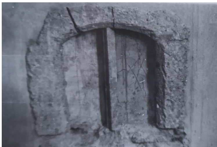
17. Ancadrament de piatră pentru fereastră la parter
