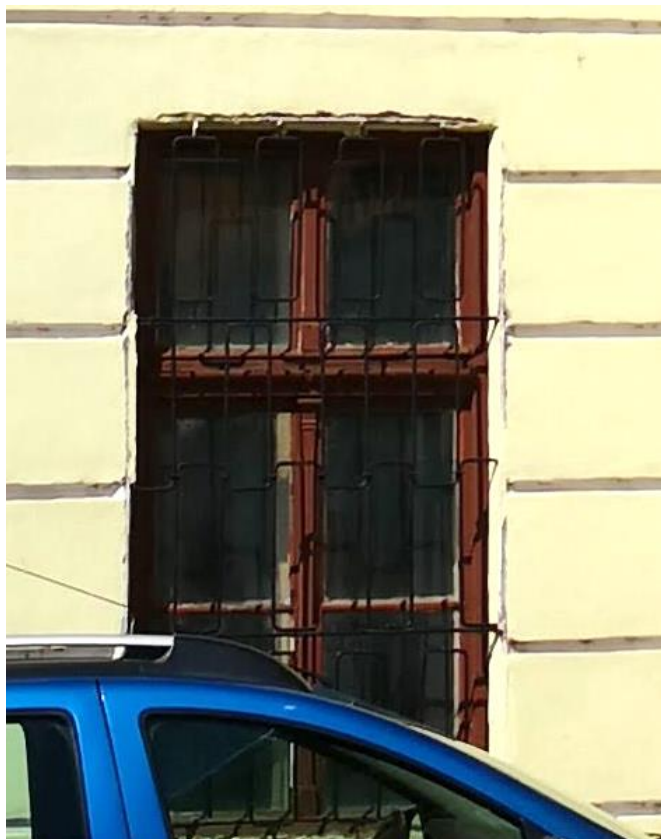
98. Fereastră montată în 1962, tâmplărie dublă de lemn, geam simplu, vopsite alb la interior și maro la exterior, grilaj metalic din bare rotunde sudate pe ramă metalică din platbandă fixată mecanic pe toc
