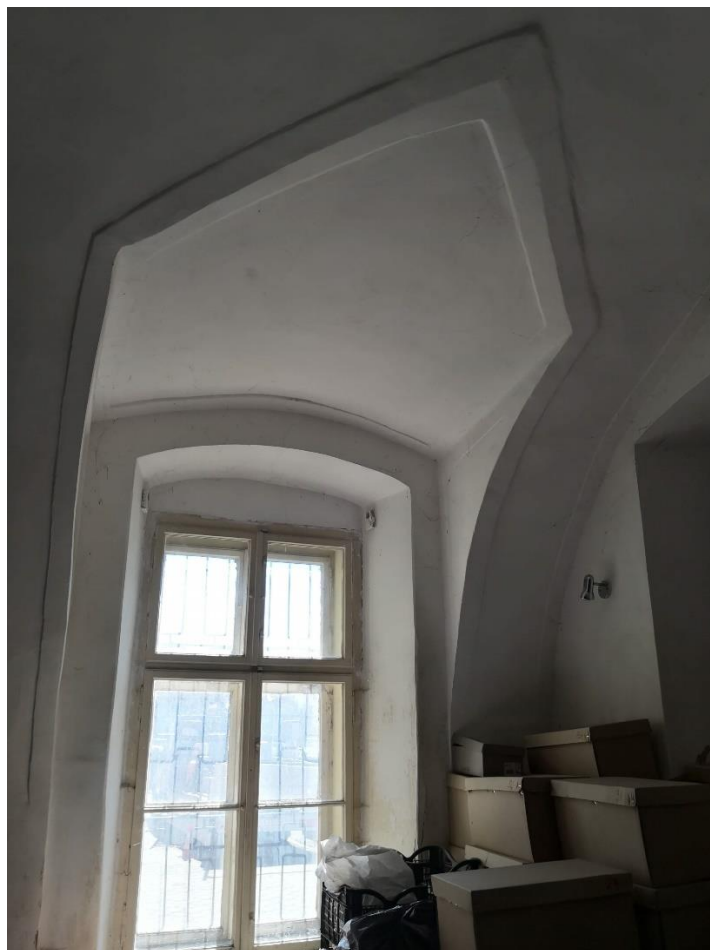
106. Model de ancadrament a penetrației în boltă pentru fereastră în P6
