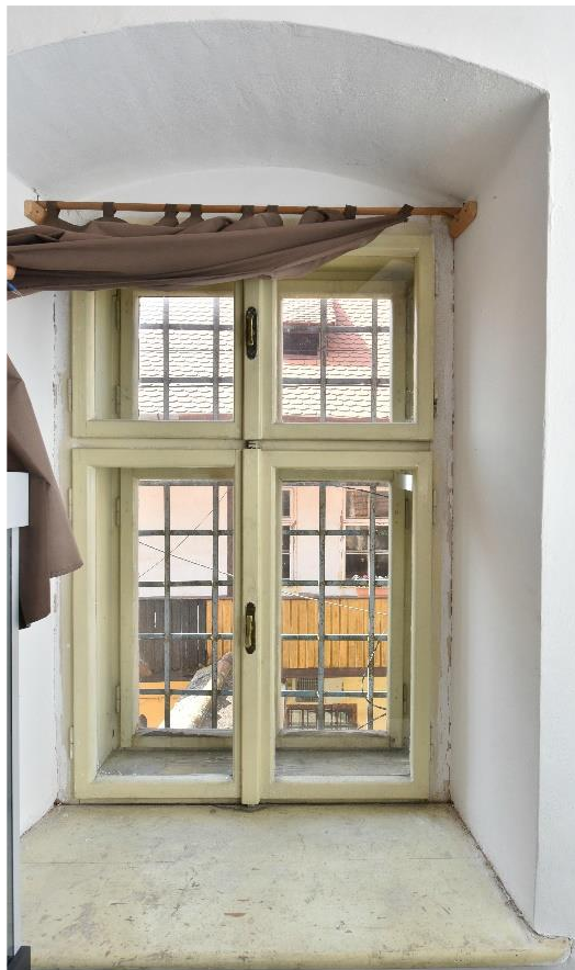
116. Fereastră montată în 1962 cu tâmplărie dublă de lemn cu geam simplu, vopsite parțial alb și grilaj metalic realizat din platbandă metalică sudată pe ramă metalică din platbandă fixat pe toc cu șuruburi și cu arc de descărcare din cărămidă aparentă
