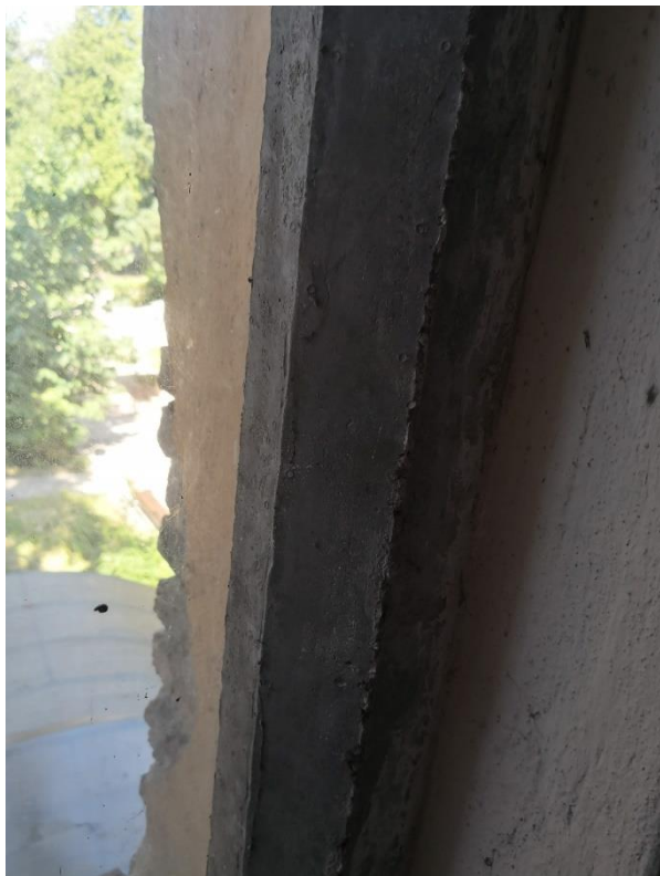
118. Fereastră montată în anul 1962 cu toc din beton armat și cu sticlă simplă montată la interior, fixată cu chit
