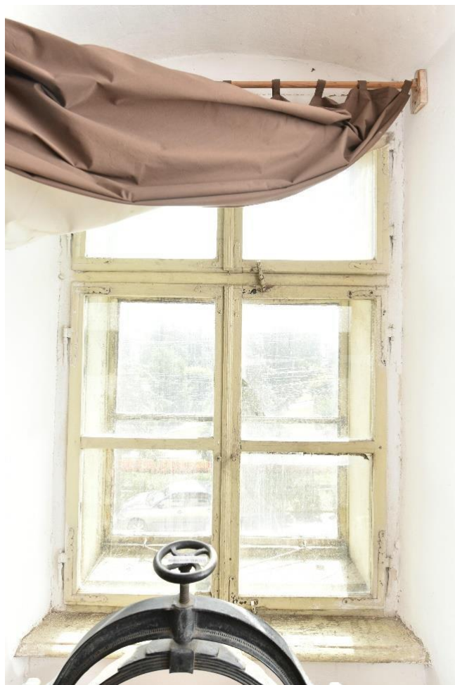
114. Ferestre cu tâmplărie dublă de lemn cu geam simplu, originale la interior cu vopsele pe bază de ulei albe, iar la exterior tâmplărie montată în 1962 și vopsită maro
