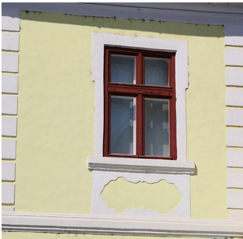
115. Fereastră montată în 1962 cu tâmplărie dublă de lemn cu geam simplu, vopsite alb la interior și maro la exterior
