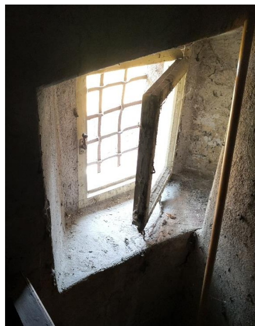
117. Gol de fereastră parțial zidit, fără tencuială, cu fereastră din lemn vopsită pe bază de ulei - alb, cu geam simplu, grilaj original din fier forjat și cu arc de descărcare din cărămidă aparentă
