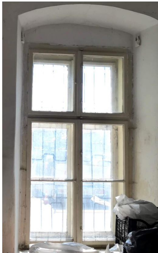
98. Fereastră montată în 1962, tâmplărie dublă de lemn, geam simplu, vopsite alb la interior și maro la exterior, grilaj metalic din bare rotunde sudate pe ramă metalică din platbandă fixată mecanic pe toc
