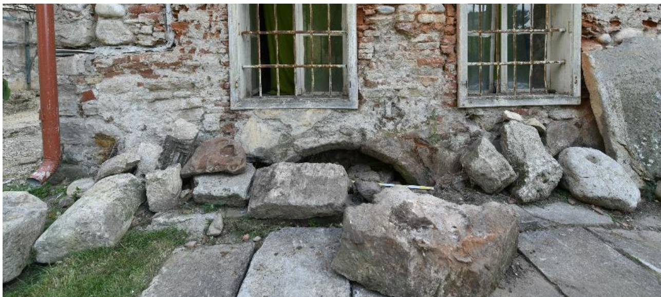
96. Ancadrament semicircular gotic din piatră cu muchie teșită, înzidit
