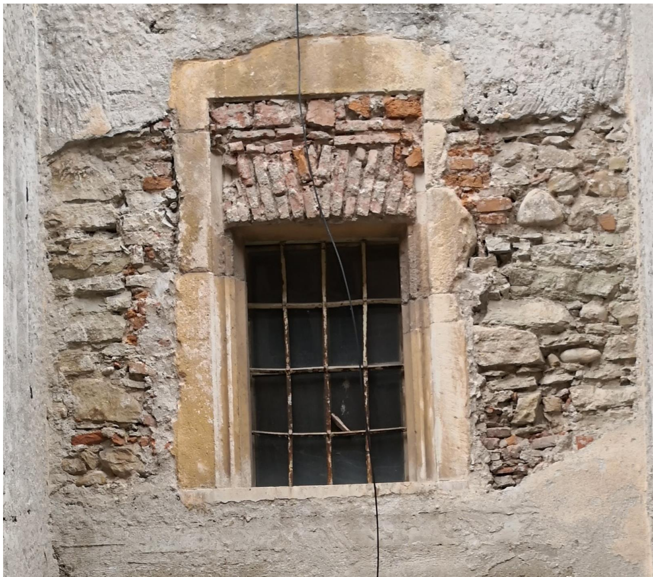
110. Fereastră cu ancadrament gotic din piatră, parțial zidit, prevăzut cu grilaj original din fier forjat, tâmplărie din lemn cu geam simplu, montată la interior și cu arc de descărcare din cărămidă aparentă
