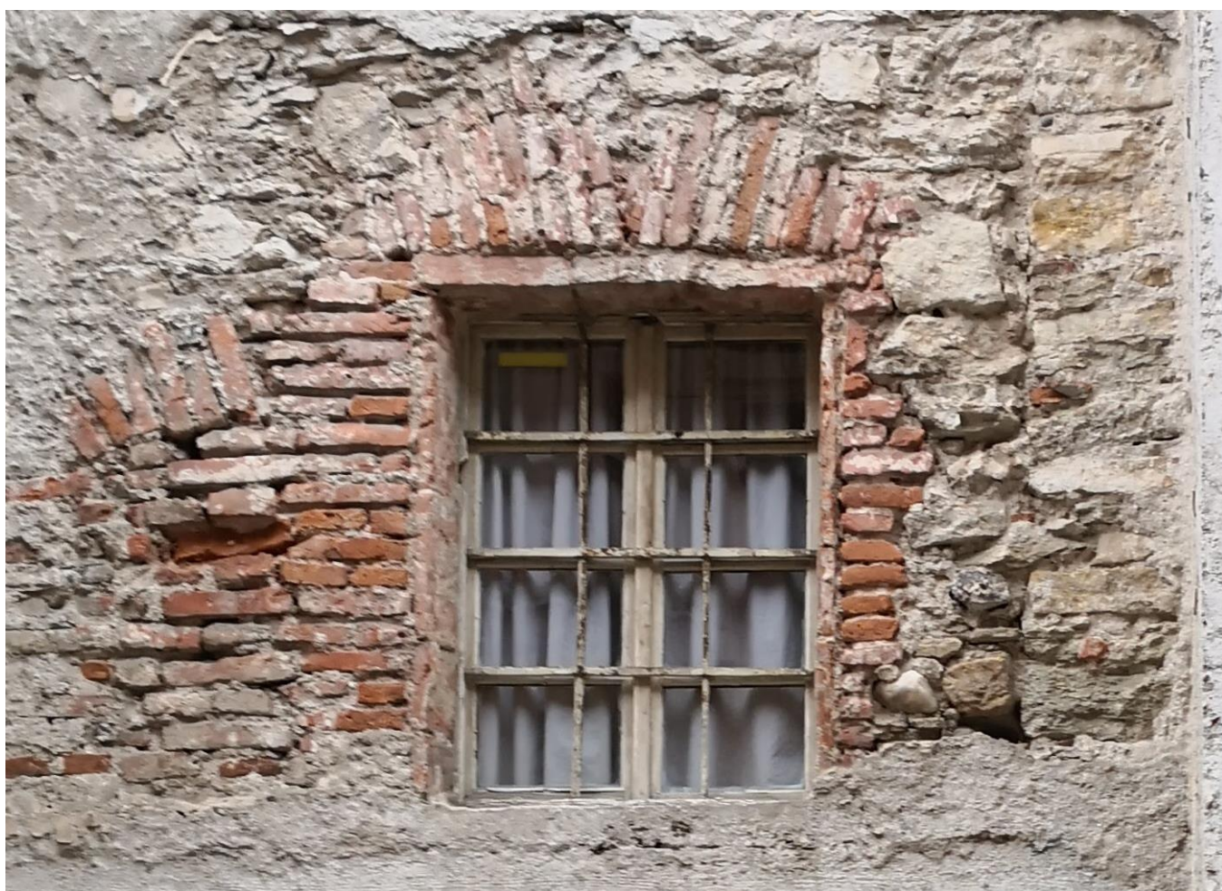
109. Fereastră originală din lemn vopsită pe bază de ulei - alb, cu geam simplu, grilaj original din fier forjat și cu arc de descărcare din cărămidă aparentă
