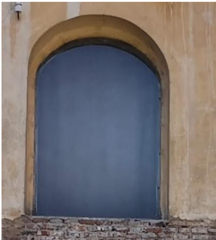
118. Fereastră montată în anul 1962 cu toc din beton armat și cu sticlă simplă montată la interior, fixată cu chit
