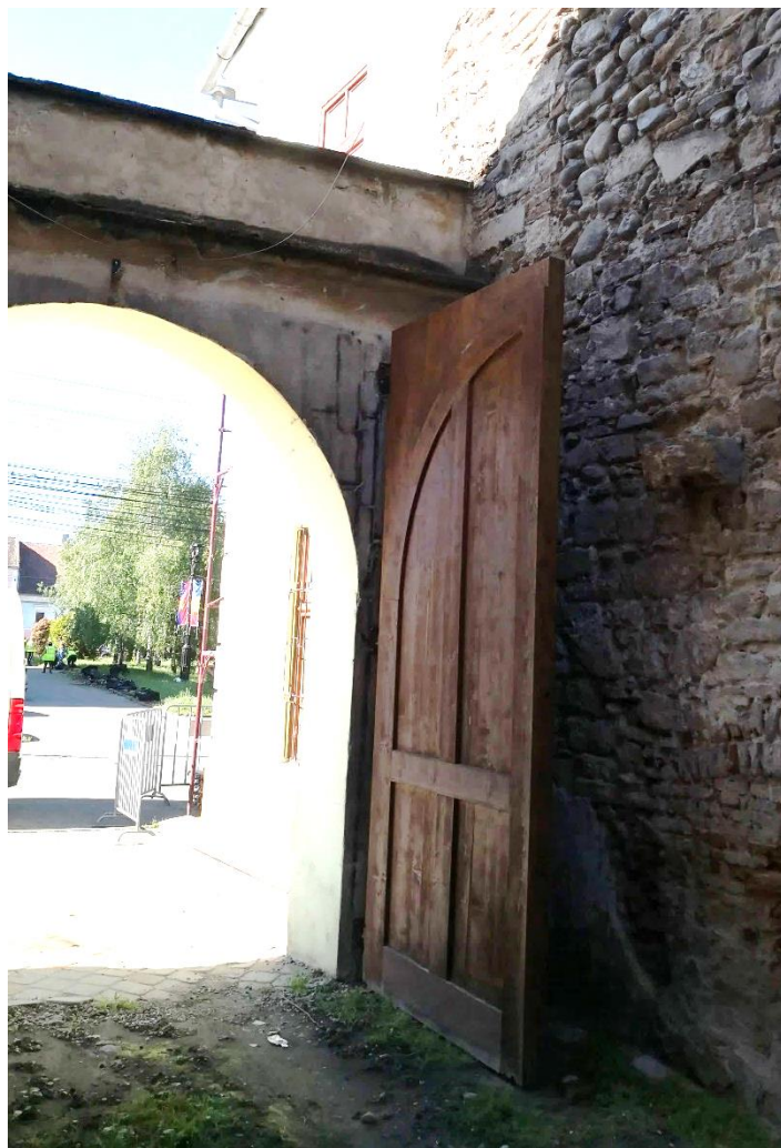
100. Poartă de lemn de factură contemporană cu scânduri aplicate pt elementele de panotaj, lăcuită maro
